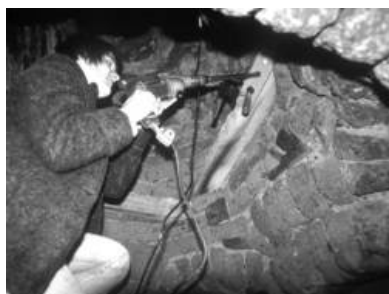
Arbeiten mit der Bohrmaschine[Bild: Gerhard Roese]
