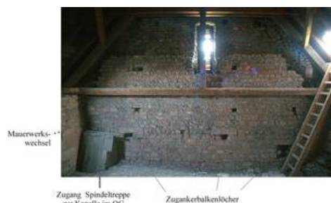
Dachraum des Westbaus[Bild: Gerhard Roese]
