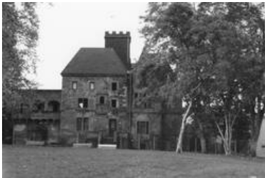
Abb. 6: Die Obere Burg bekommt ein neues Dach. [Bild: Heimatverein Rheinbreitbach]
