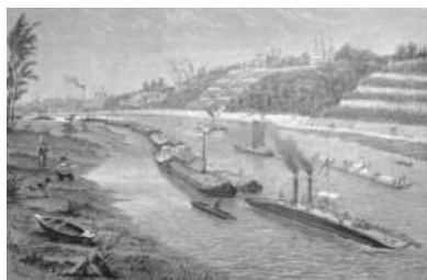
Kettendampfer auf der Elbe bei Dresden, der eine Vielzahl von Schleppkähnen flussaufwärts zieht, etwa 1880[Bild: Wikipedia]
