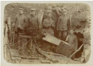
Erschöpfte Soldaten beim Stollenbau/Bunkerbau unter primitivsten Bedingungen.
