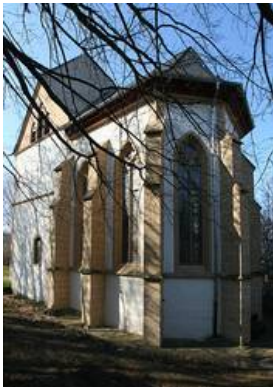
Östlich gesehen wird der Chor von St. Wigbert von sechs zweifach mit Traufkanten abgetrepten Strebepfeilern gestützt.
