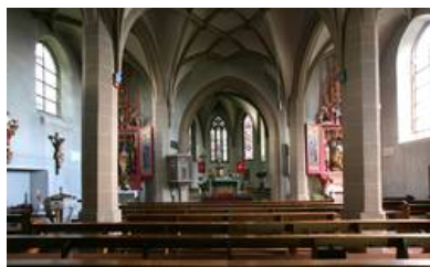
Der Innenraum der Kirche ist in drei gleich große Schiffe mit einem Gewölbe aus drei Jochen gegliedert.
