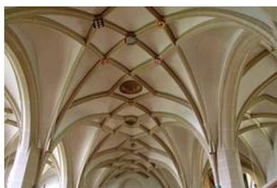
Das Gewölbe wird von je drei achteckigen Pfeilern getragen.
