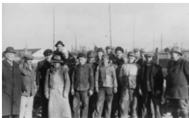
Fremdarbeiter bei Giuliani während des Baus von Hilfsbaracken als Ersatz zerstörter Bürogebäude, 1942[Bild: Stadtarchiv Ludwigshafen]
