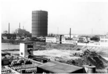
Blick über den Industriehafen hinweg Richtung Ingelheimer Aue mit dem Gaskessel (Gasometer), 1964.[Bild: StA Mainz, BPSF 5485a]
